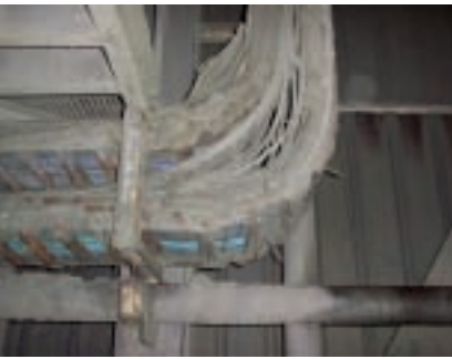
Figura 3. Bandejas porta cable atascadas por la corrosión
