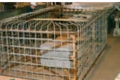
Figura 7. Refuerzo con FIBROBARRAS para celdas de procesos electrolíticos.
